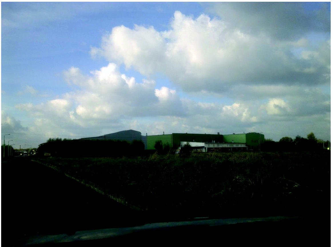
Fot.2 widok na fragment obszaru A, sąsiadujące zabudowania produkcyjno-usługowe
